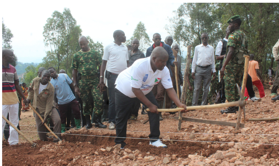
Le MDNAC dans les travaux communautaires à l'ECOFO Musumba
